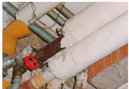
Asbesthaltiger Mörtel zur Rohrisolation
